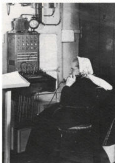
Afb. 3. Oude handcentrale in Vlissingen.
